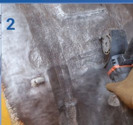
2 Préparation de surface Sa2½ / St3 et rugosité Rz > 60 µm
