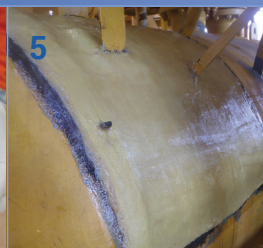
5 Application du patch de Kevlar® imprégné avec résine 3X
